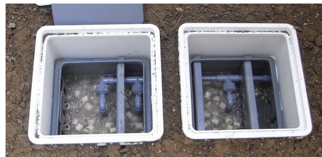
内部稼働状況
